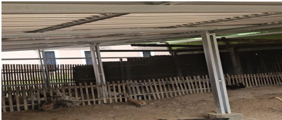
Gambar 3. Implementasi Bangunan Kandang Hygienis tidak lagi di Kolong Rumah
