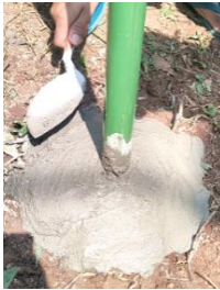
Gambar 3. 12 Tatakan semen antara tiang dengan tanah
