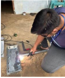
Gambar 3. 1 Mengelas frame dan tiang besi
