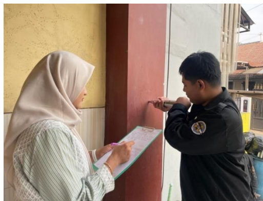
Gambar 8. Pelaksanaan hammer test pada elemen struktur.
