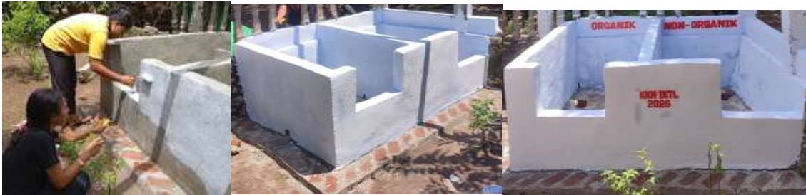
Gambar 6. Proses Pengecatan Bak Sampah.
