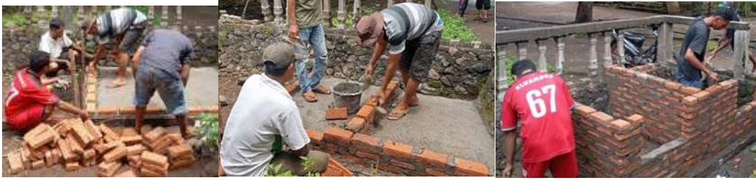
Gambar 5. Penyusunan Batu Bata.
