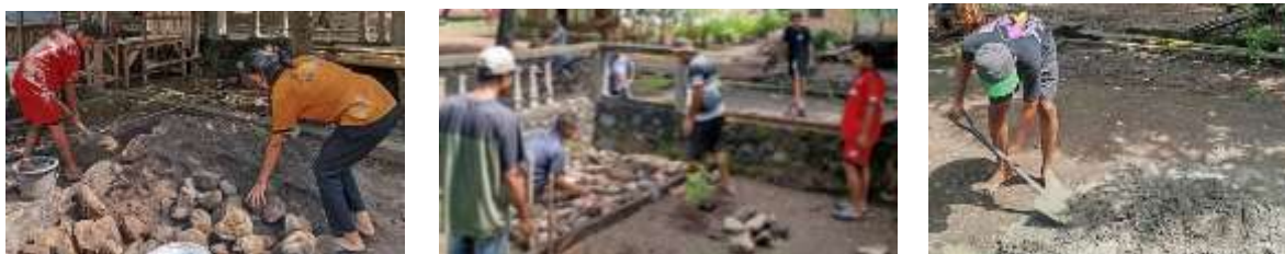
Gambar 4. Proses Pembuatan Fondasi Bak Sampah
